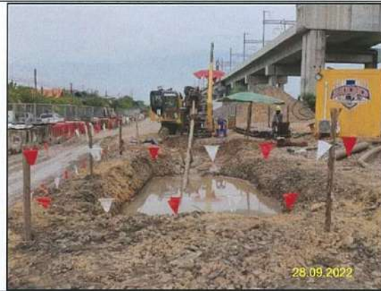
ค) การวางท่อโดยวิธีเจาะลอด (HDD)
